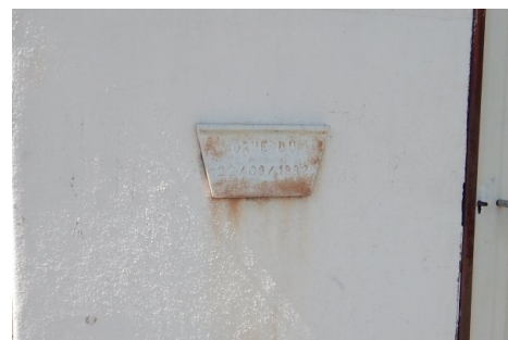
Zoom sur le repère de crue.
