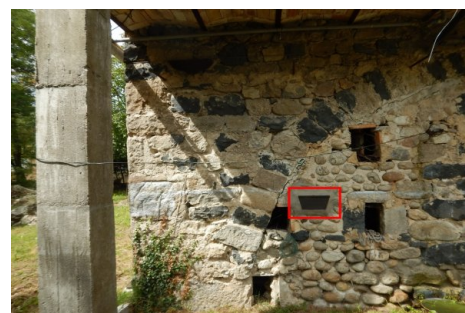
Localisation du repère - vue d'ensemble. Prise de vue : Août 2014 - EPTB Ardèche
