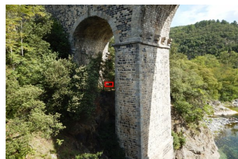
Localisation du repère - vue d'ensemble. Prise de vue : Août 2014 - Ardèche Claire
