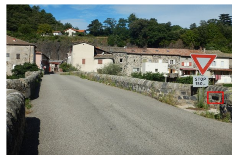
Localisation du repère - vue d'ensemble. Prise de vue : Août 2014 - EPTB Ardecbe
