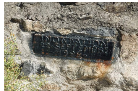
Zoom sur le repère de crue. Prise de vue : Août 2014 - EPTB Ardecbe
