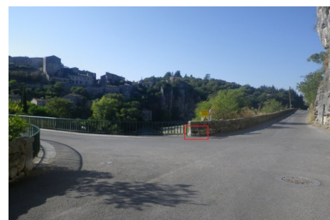
Localisation du repère - vue d'ensemble. Prise de vue : Septembre 2018 - EPTB Ardèche
