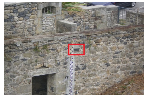
Zoom sur le repère de crue. Prise de vue : Septembre 2017 - EPTB Ardèche
