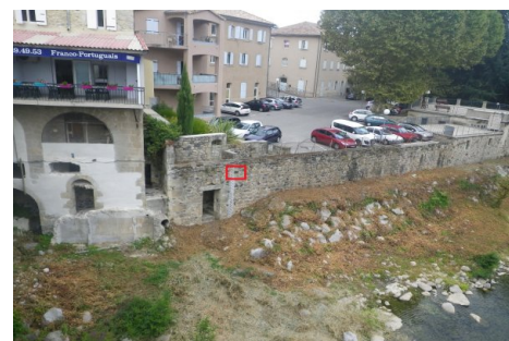
Localisation du repère - vue d'ensemble. Prise de vue : Septembre 2017 - EPTB Ardèche
