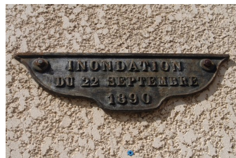
Zoom sur le repère de crue. Prise de vue : Octobre 2017 - EPTB Ardèche
