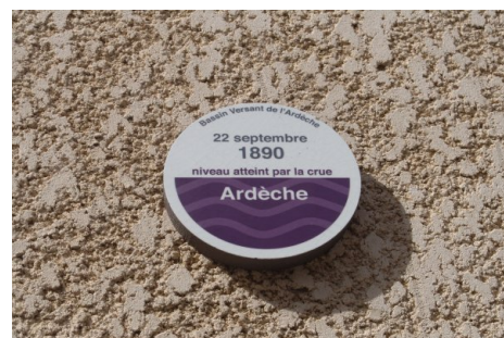
Zoom sur le repère de crue. Prise de vue : Octobre 2017 - EPTB Ardèche
