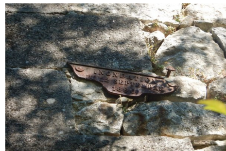
Zoom sur le repère de crue. Prise de vue : Septembre 2014 - Ardèche Claire
