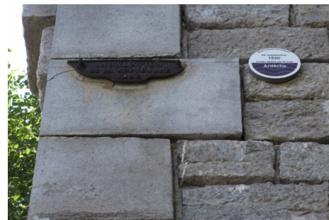
Zoom sur le repère de crue. Prise de vue : Août 2014 - Ardèche Claire
