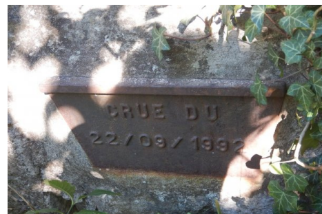
Zoom sur le repère de crue. Prise de vue : Septembre 2014 - Ardèche Claire
