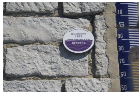
Zoom sur le repère de crue. Prise de vue : Septembre 2018 - EPTB Ardèche
