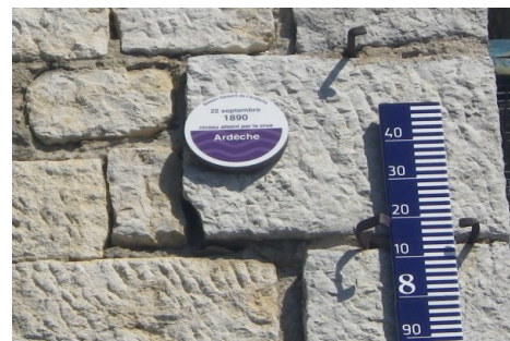
Zoom sur le repère de crue.
